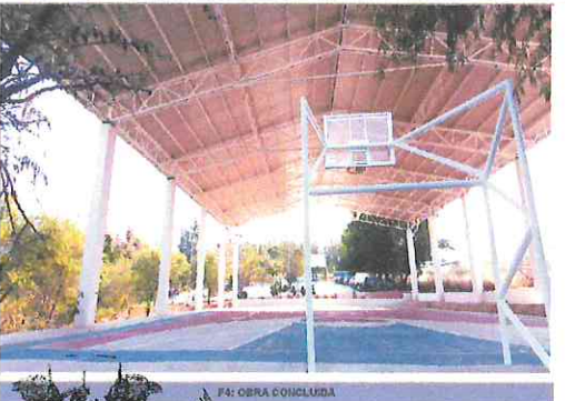
F4: OBRA CONCLUIDA
