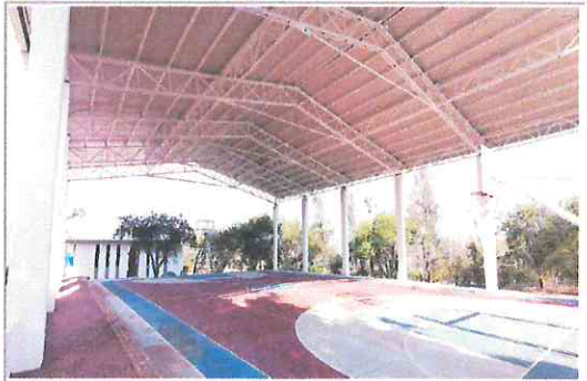
F2: OBRA CONCLUIDA
