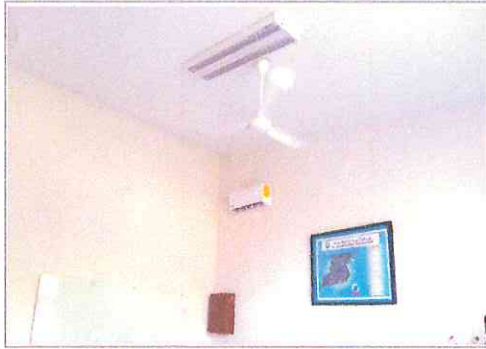
F1: INSTALACION DE LAMPARAS EN VICE-RECTORÍA DE ADMON.
