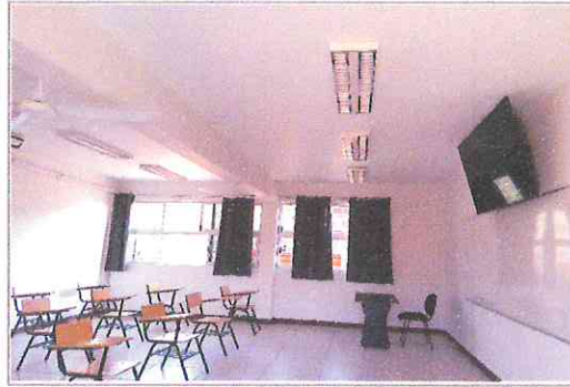
F2: INSTALACION DE LAMPARAS EN AULAS
