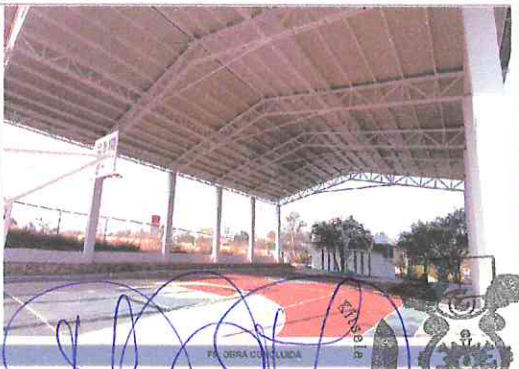
F5: OBRA CONCLUIDA
