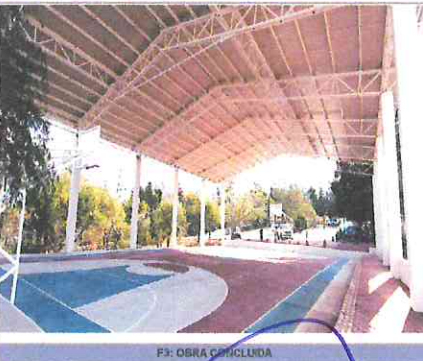
F3: OBRA CONCLUIDA
