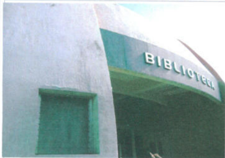
F1: Fachada principal Biblioteca
