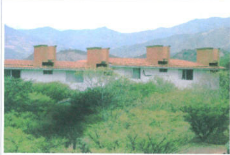
F1: Fachada posterior del Edificio
