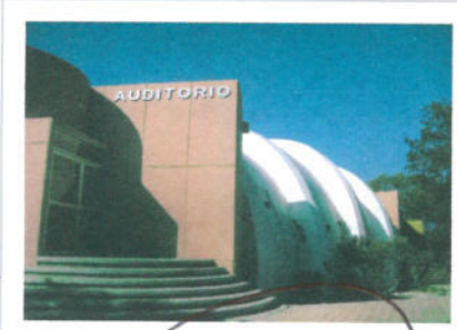
F3: Fachada Auditorio
