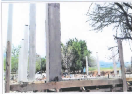
F1: concreto armado en columnas
