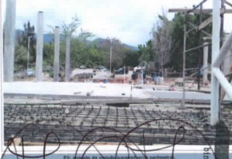
F5: piso de concreto armado en portera.
