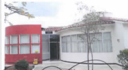
F5: Fachada edificio Oficina de Obras y Mantenimiento de la ES
