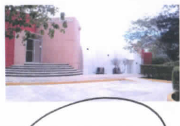
F3: Fachada Auditorio (impermeabilizada y pintura)
