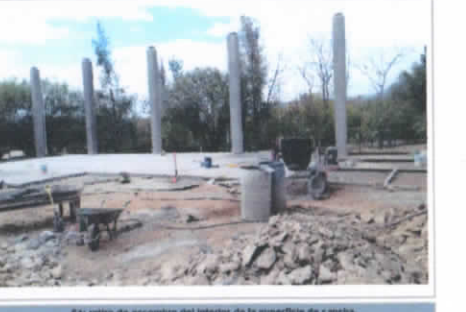
F4: retazo de acero del interior de la superficie de cancha.
