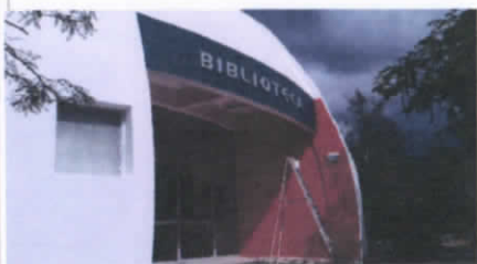
F1: Fachada principal Biblioteca (edificación pintada e impermeabilizada)
