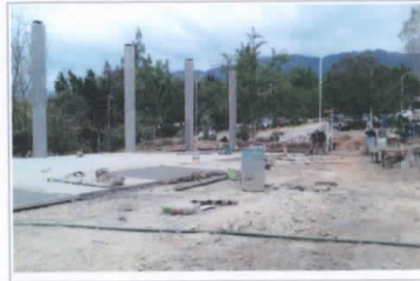
F2: piso de concreto f'c=200 kg/cm2
