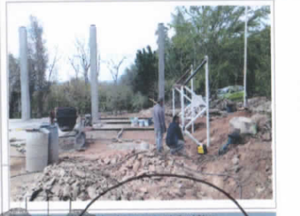
F3: estructura de acero para portera y tablero.
