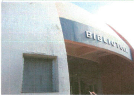
F1: Fachada principal Biblioteca
