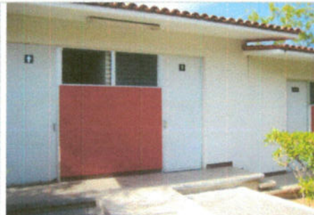
F4: Puertas CAPCE del edificio de Aulas
