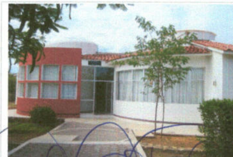
F5: Fachada Centro de Ciencias
