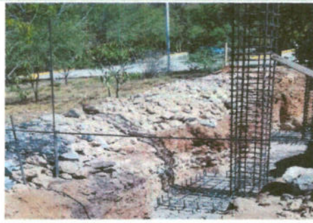
F2: Acero de refuerzo en columnas en zapatas aisladas y colado de planilla
