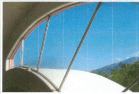
F2: Area Superior de Biblioteca para instalar Domo
