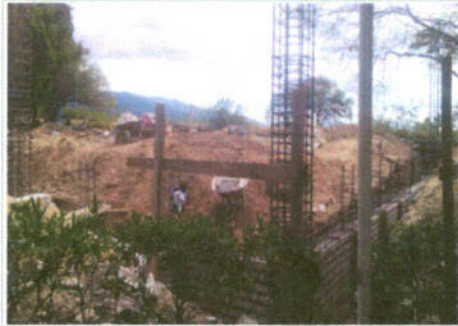
F1: habilitado, armado y colocado de acero de refuerzo en columnas
