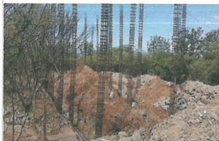
F2: acero de refuerzo en cimentación.
