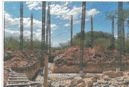
F4: acero de refuerzo en cimentación y plantilla.
