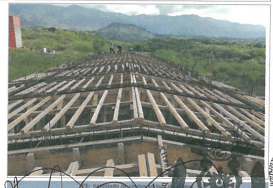
F5: habitación de cimbra en losa de azotea
