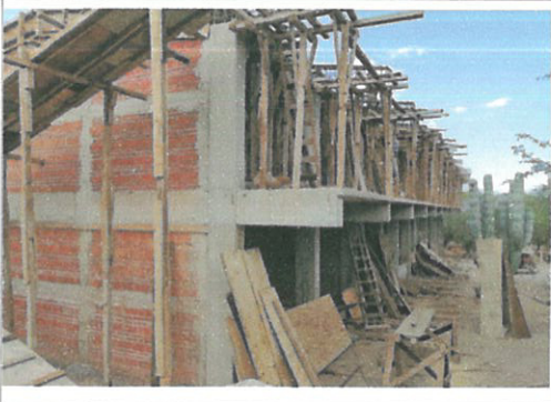
F1: Inicio de labo de estructura para traves y columnas, estado de columnas y piso 0001 en P.A.
