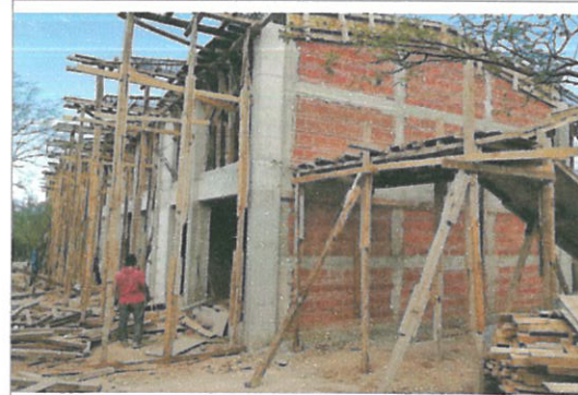
F2: Cimbrado de traves y volado de losas.
