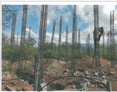
F3: acero de refuerzo en cimentación.
