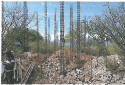
F1: acero de refuerzo en cimentación.
