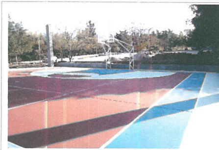
F2: Cancha de Usos Múltiples Concluida
