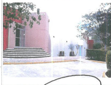
F3: Fachada Auditorio (impermeabilizado y pintado)
