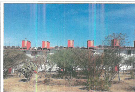
F4: Fachada posterior (instalacion de calentadores solares)
