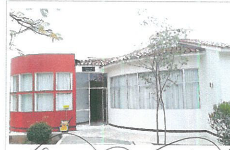
F5: Fachada Centro de laboratorios (pintado)
