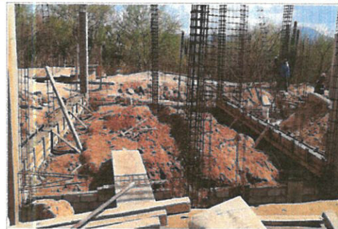
F2: Colado de la cimentación.
