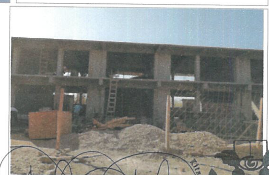
F5: Relleno, aplonado y estuco en juntas altas y bajas.
