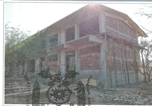
F4: Descibrado de losa de azotea, muro de tabique de 14 cm.
