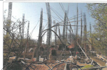
F5: acero de refuerzo en estructuras.
