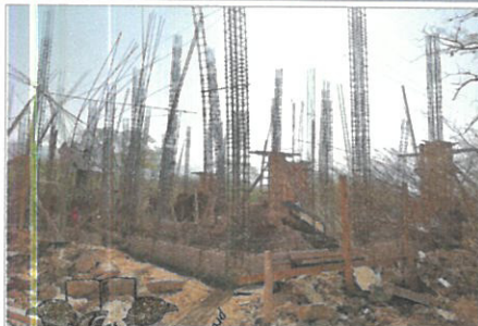
F4: acero de refuerzo en estructuras.
