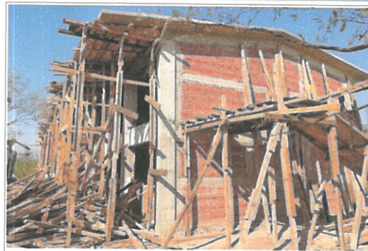
F2: Descibrado de traveses y volado de losa de azotea.
