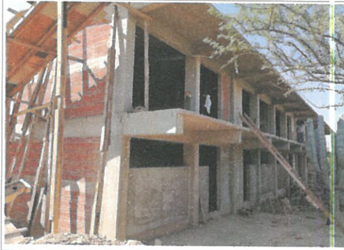
F1: Colado de losa de azotea, aplonado de muros de 14 cm.
