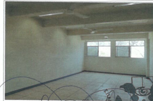
F5: Interior de la obra.
