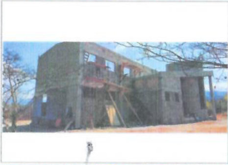
1.1. Substitución del acero de refuerzo total y trabes.
