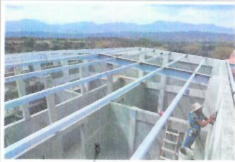
F1. Colocación de vigas y malla de acero para techado
