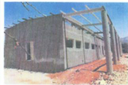
F3. Aplazado Fino, y colocación de vigas de acero para techado
