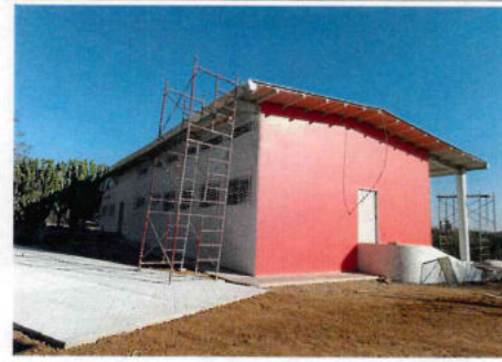
F2: ESTRUCTURA, ALBAÑILERÍA Y ACABADOS, CANCELERÍA Y HERRERÍA, OBRA EXTERIOR.
