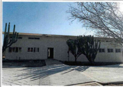
F1: ESTRUCTURA, ALBAÑILERÍA Y ACABADOS, CANCELERÍA Y HERRERÍA, OBRA EXTERIOR.
