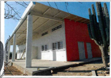
F3: ESTRUCTURA, ALBAÑILERÍA Y ACABADOS, CANCELERÍA Y HERRERÍA, OBRA EXTERIOR.
