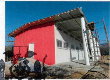
F4: ESTRUCTURA, ALBAÑILERÍA Y ACABADOS, CANCELERÍA Y HERRERÍA, OBRA EXTERIOR.
