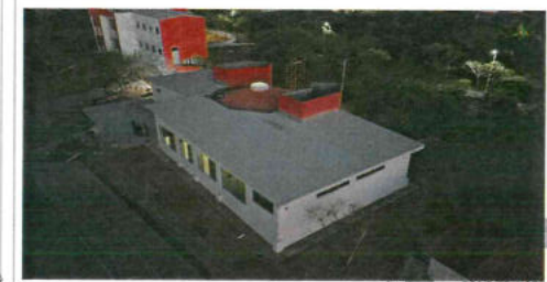
OBRA TERMINADA, BANQUETAS
