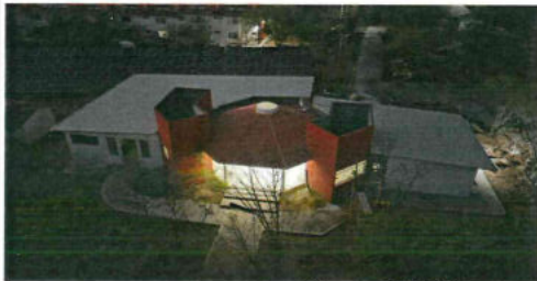
OBRA TERMINADA, FACHADA EXTERNA
