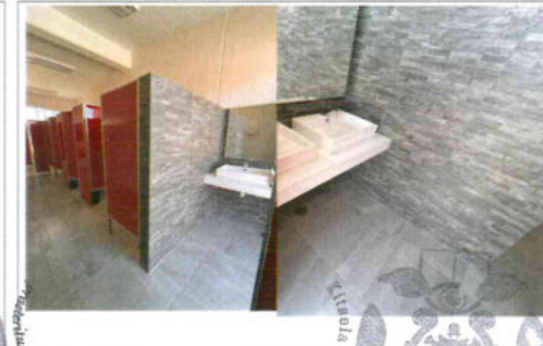
MAMPARA DE CONCRETO PORMARCA CON ABOLADO
