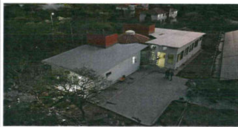
OBRA TERMINADA, PAVIMENTO DE PATIO DE SERVICIO
