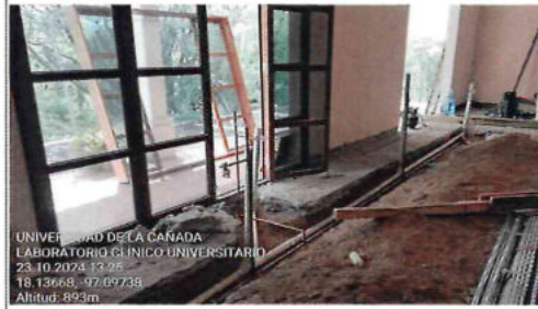
EXCAVACIÓN Y PREPARACIÓN DE INSTALACIONES HIDRO-SANITARIAS Y ELÉCTRICAS.
