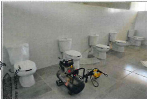
COLOCACIÓN DE MUEBLES WC
