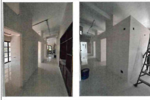
PINTURA EN MUROS Y PLAFONES
