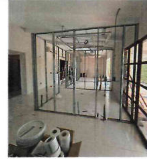
COLOCACIÓN DE MALLA Y PLAFONES DE BARRICK.
