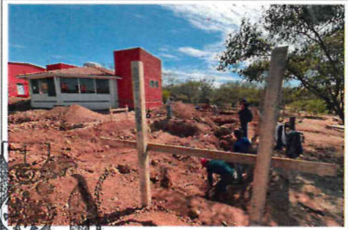
EXCAVACIÓN EN MATERIAL TIPO C
