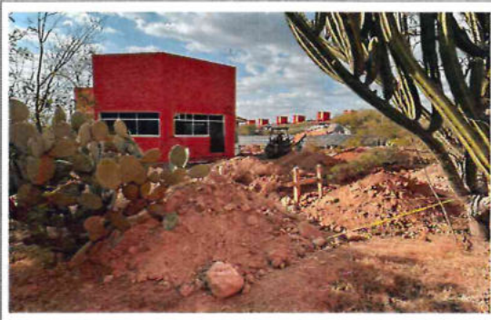
EXCAVACIÓN DE CIMENTOS POR MEDIOS MECÁNICOS
