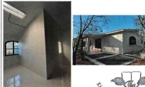
PINTURA EXTERIOR Y ACABADOS FINALES EN OBRA INTERIORES
