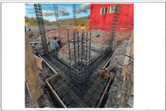
COLOCACIÓN Y CUBRADO DE CIMENTOS DE ZAPATAS CORRIDAS Y AISLADAS
