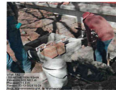
CONSTRUCCIÓN DE REGISTROS SANITARIOS
