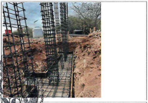
COLOCACIÓN Y CUBRADO DE CIMENTOS, ZAPATAS CORRIDAS Y AISLADAS
