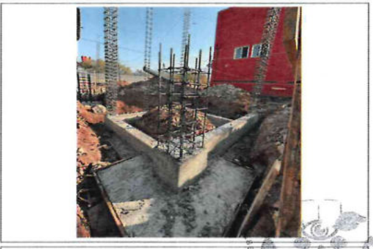
COLOCACIÓN Y CUBRADO DE CIMENTOS, ZAPATAS CORRIDAS Y AISLADAS
