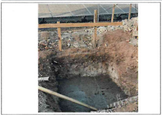
COLADO DE PLANTILLAS DE CIMENTACIÓN
