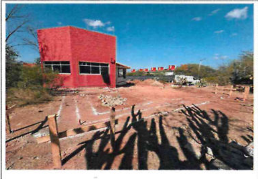
TRAZO, LIMPIEZA Y DESPALME DEL TERRENO
